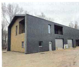
Curage des lacs et création d'un nouveau local technique au golf de Mâcon.
