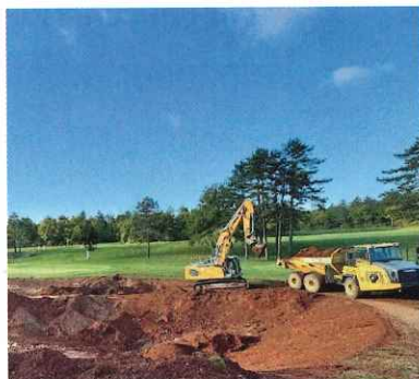
Les travaux de construction du nouveau bassin d'eau vont bon train à La Chassagne.
