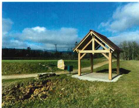
Le carbet du starter est en place au trou 1 du golf de La Chassagne.
