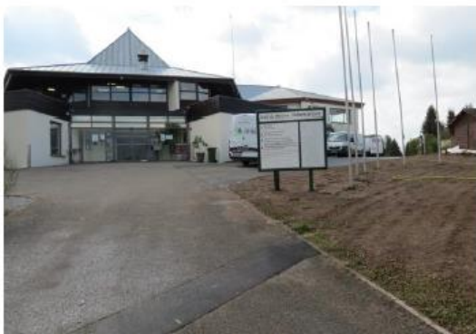
Le chantier se termine. À l'avant, il reste à semer la pelouse.
