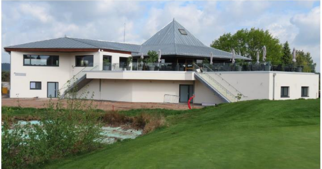
La structure principale, en bois, a été conservée. Mais l'ensemble du club-house a été agrandi.
