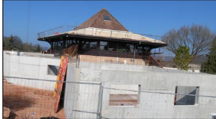
Les travaux de gros œuvre sont en cours au golf.
